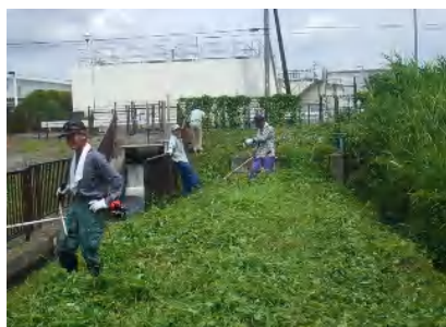
開水路の草刈り
