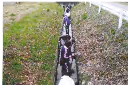
（水路の泥上げ）
