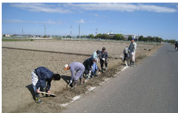
開水路の清掃
