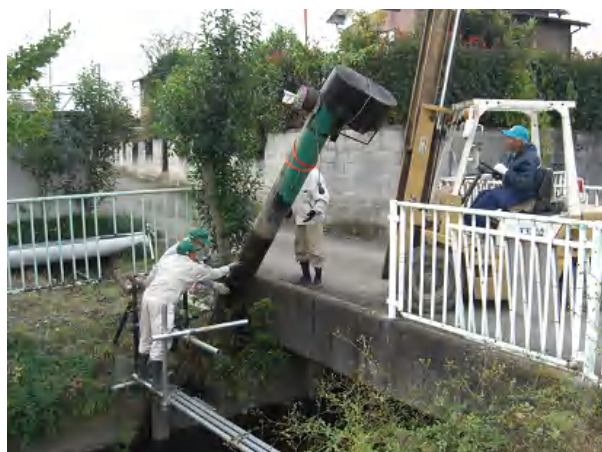
バチカルポンプの引き上げ
