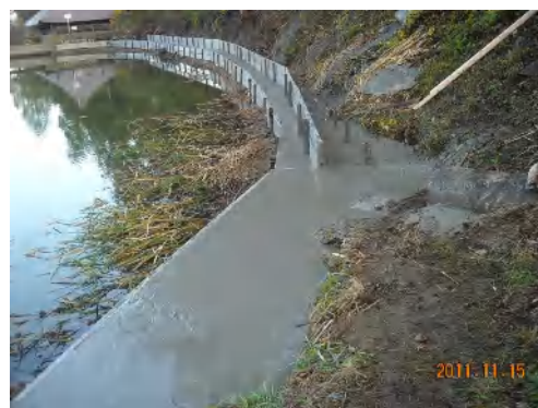
ため池・堤体のコンクリート打設
