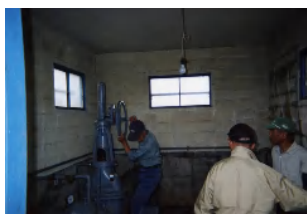
①施設の点検・機能診断
